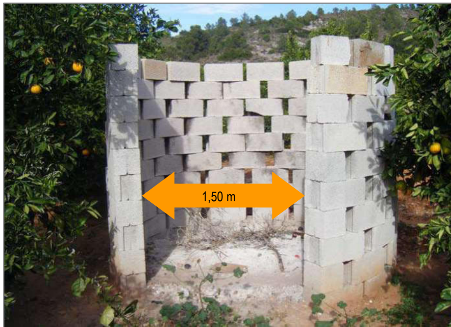
Foto 1. Abertura lateral o boca de alimentación de un quemador agrícola.
